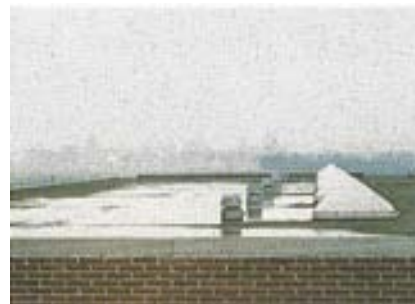
Fig. 4. Vandansamling på fladt tag.
